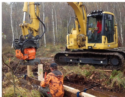
Pose de madriers pour restaurer le fonctionnement hydraulique de la tourbière ©L. Bettinelli - 2025
