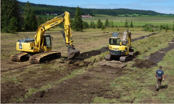
Bouchage de fossés de drainage au sein de la tourbière du Moutat (Mouthe, Doubs). Près de 35 km de fossés de drainage auront été neutralisés durant la décennie. ©P. Durlet
