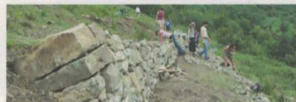
Travaux lors du chantier 2009 : 28,50 mètres de murettes en pierre sèche restaurés.
