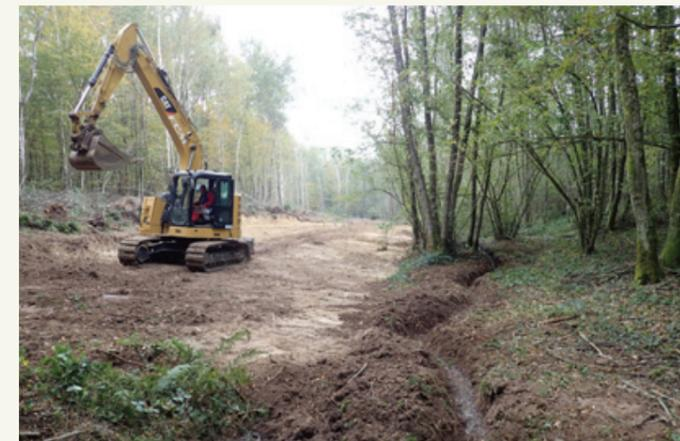
Travaux de reméandrement du ruisseau sur les tourbières des Grandes Mouilles à Cresancey (70). Des fossés de drainage ont également été comblés. Ces travaux permettent de rétablir le fonctionnement hydrologique des tourbières.
