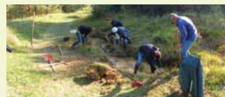
Les chantiers nature sont également utiles pour valoriser un site et sensibiliser le public local.
