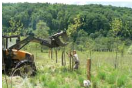
Pose de clôture pour la mise en place de pâturage sur le bas-marais à Ménétrux-en-Joux (39)
