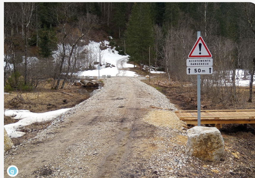
Aspect de la route 6 mois après travaux
