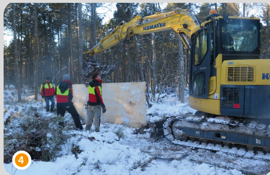
Pose de palissade en panneau tripli
