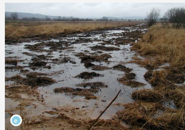
e Colmatage du fossé exutoire nord en marne et tourbe réalisé en 2004
