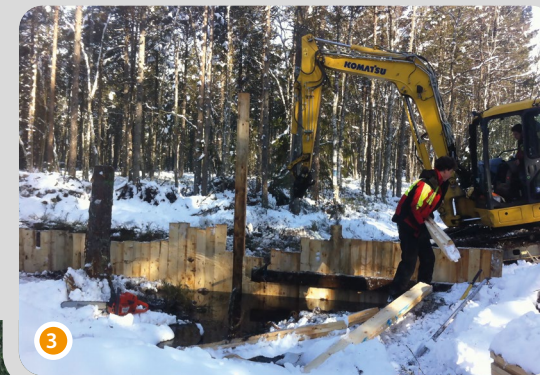
Pose de palissade en madrier de bois
