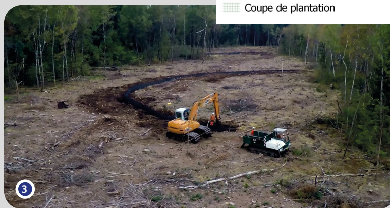
Barrage n° 3 en cours de réalisation
