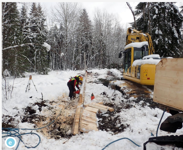
Travaux pendant des conditions météorologiques défavorables
