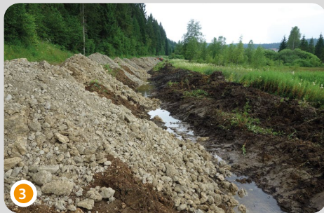
La moraine a été choisie pour combler le collecteur sud car le volume nécessaire était important, l'accès était facile et le fossé était situé le long du versant, donc sous influence importante des eaux minéralisées
