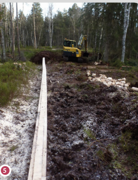
Couverture des palissades en madrier de bois avec la tourbe puis la végétation
