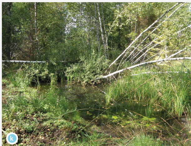
Ouvrage à l'aval après deux saisons de végétation septembre 2019
