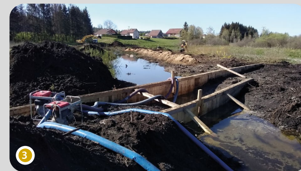
Construction de la double palissade au niveau du fossé central
