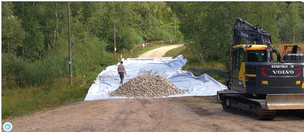
Rechargement en matériau calcaire dur de dimension 80/150, sur géotextile perméable
