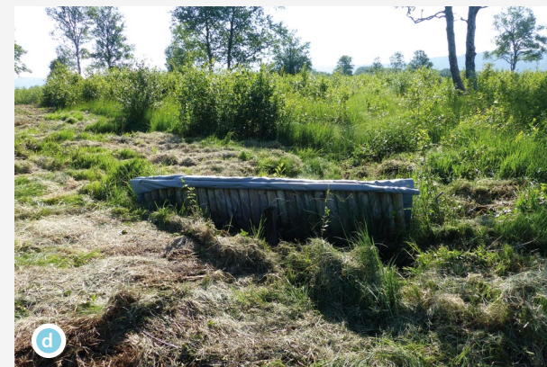
d 2018 : un des deux barrages contournés, ouvrage réalisé en 1996
