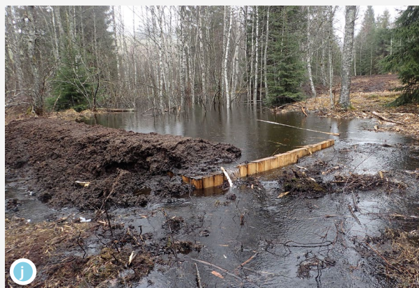
Prolongement de la digue avec des chutes de madriers recouverts par la suite de tourbe
