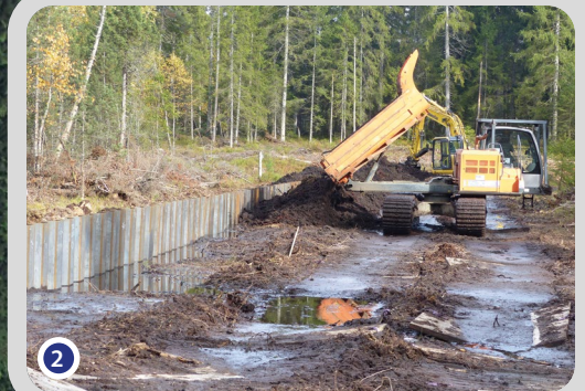
Digue métallique de compensation topographique, couverte de tourbe
