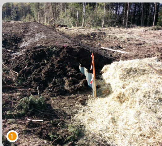
Barrage n° 1 façonné (sauf extrémités), avant paillage
