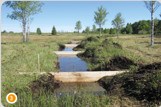
Etape 1 de neutralisation de fossé : pose des panneaux de bois
