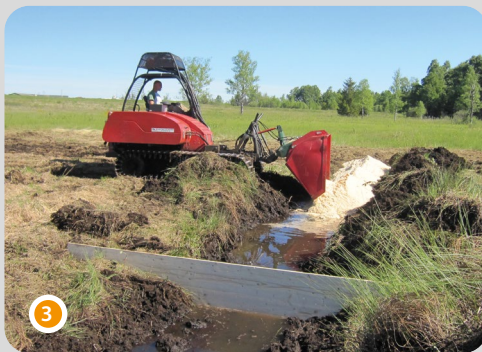
Etape 2 de la neutralisation de fossé : remplissage du canal de sciure
