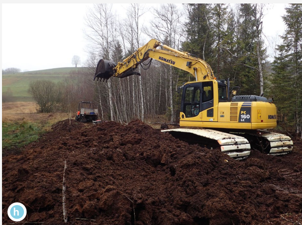
Travaux de consolidation fin novembre 2018
