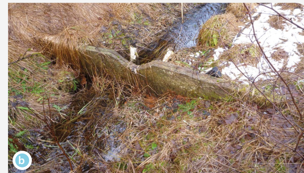
Ancien panneau de bois, contourné, ne jouant plus son rôle de barrage
