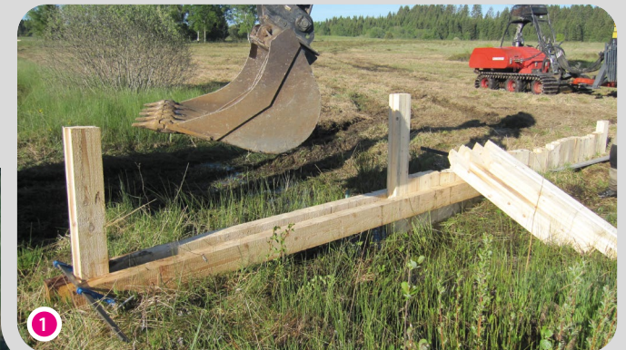
Pose de palissade bois
