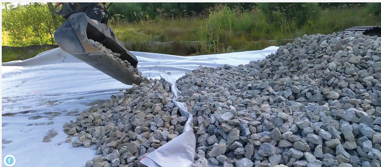
Mise en place d'une feuille de géotextile à perméabilité réduite. Enchâssées tous les 5 mètres, en travers de l'empierrement, ces feuilles empêchent l'eau de circuler longitudinalement dans le remblai (limitant son effet drainant) et les dirigent préférentiellement de l'autre côté de la route, vers l'aval de la tourbière
