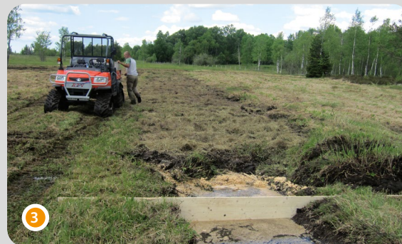
Etape 3 de la neutralisation de fossé : couverture de la sciure par la tourbe issue du curage de la tourbe minéralisée
