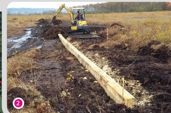
Couverture en tourbe d'une digue palissade bois simple. Pour ne pas créer d'ornièrre drainante, la pelle travaille sur des plaques
