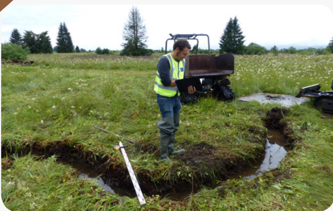
Les travaux ont débuté le 15 juillet et devraient se terminer fin septembre.
