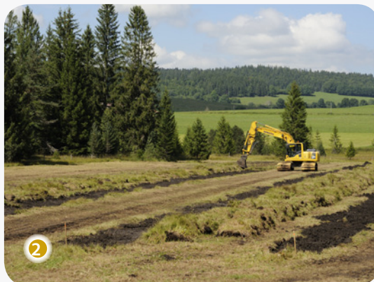
Le Moutat à Mouthe (25) (PNR du Haut-Jura) : 1152 m de drains neutralisés, 256 m de cours d'eau reméandré, 0,5 ha de fosses remises en eau, 337 m de clôtures installés • Découvrez les travaux en vidéo sur :
