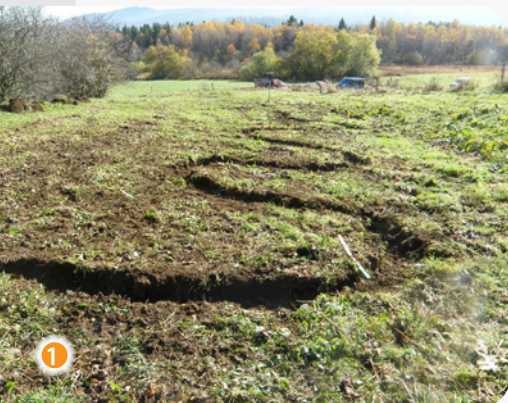
La tourbière du Crossat à Remoray-Boujeons (25) (Les Amis de la Réserve naturelle nationale du lac de Remoray) : 70 m de drains neutralisés, 893 m de cours d'eau reméandrés
