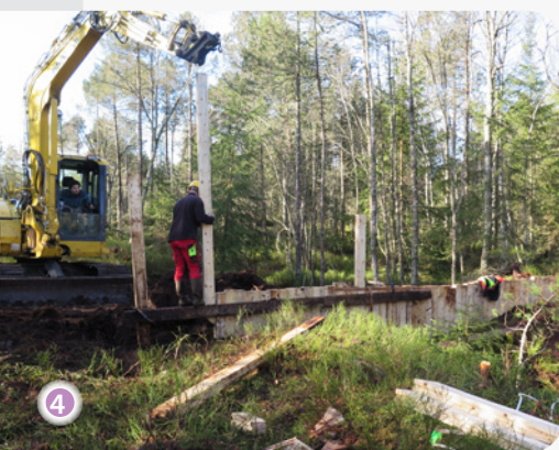
La Seigne des Guinots au Russey et Bonnéage (25) (Syndicat mixte d'aménagement du Dessoubre) : 415 m de drains neutralisés, 1 ha de fosses remises en eau
