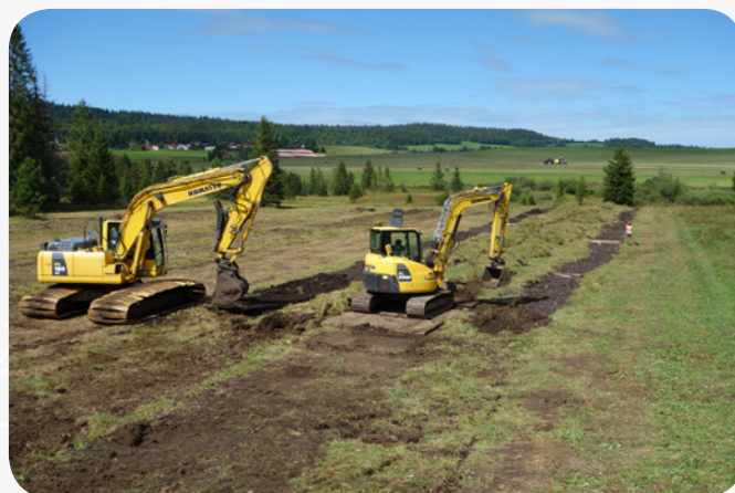
Oblitération de 1 100 mètres de fossés de bas-marais
