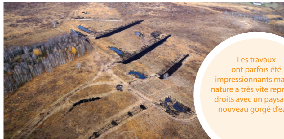
Travaux de réhabilitation de la Grande Seigne à Houtaud et aux Granges-Narboz (25)
