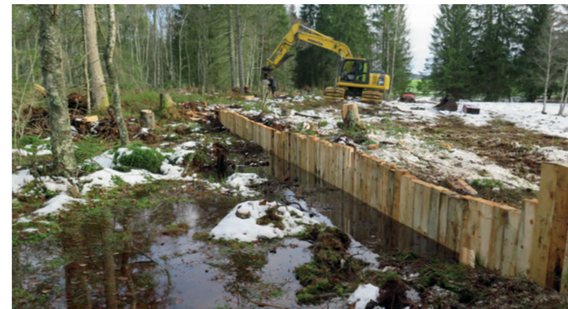
Travaux en cours de réalisation aux Cerneux-Gourinots à Fournet-Blancheroche (25)
