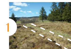
Fossé drainant une fosse d'exploitation
