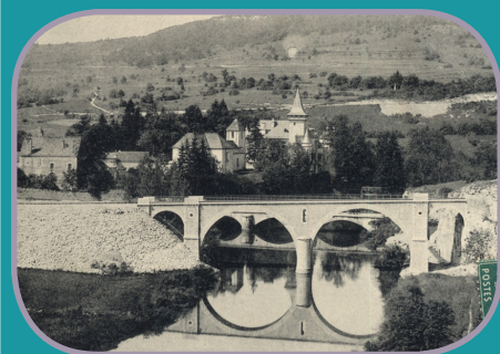
Vue depuis l'amont du viaduc de Cléron après 1910 : remarquons l'ouverture du paysage au dessus du village, en direction d'Amondans.
