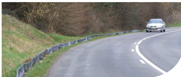
A Pontcey, un système de bache est installé sur près de 1250 m le long de la route avec des seaux enterrés tous les 25 m © C. Morin
